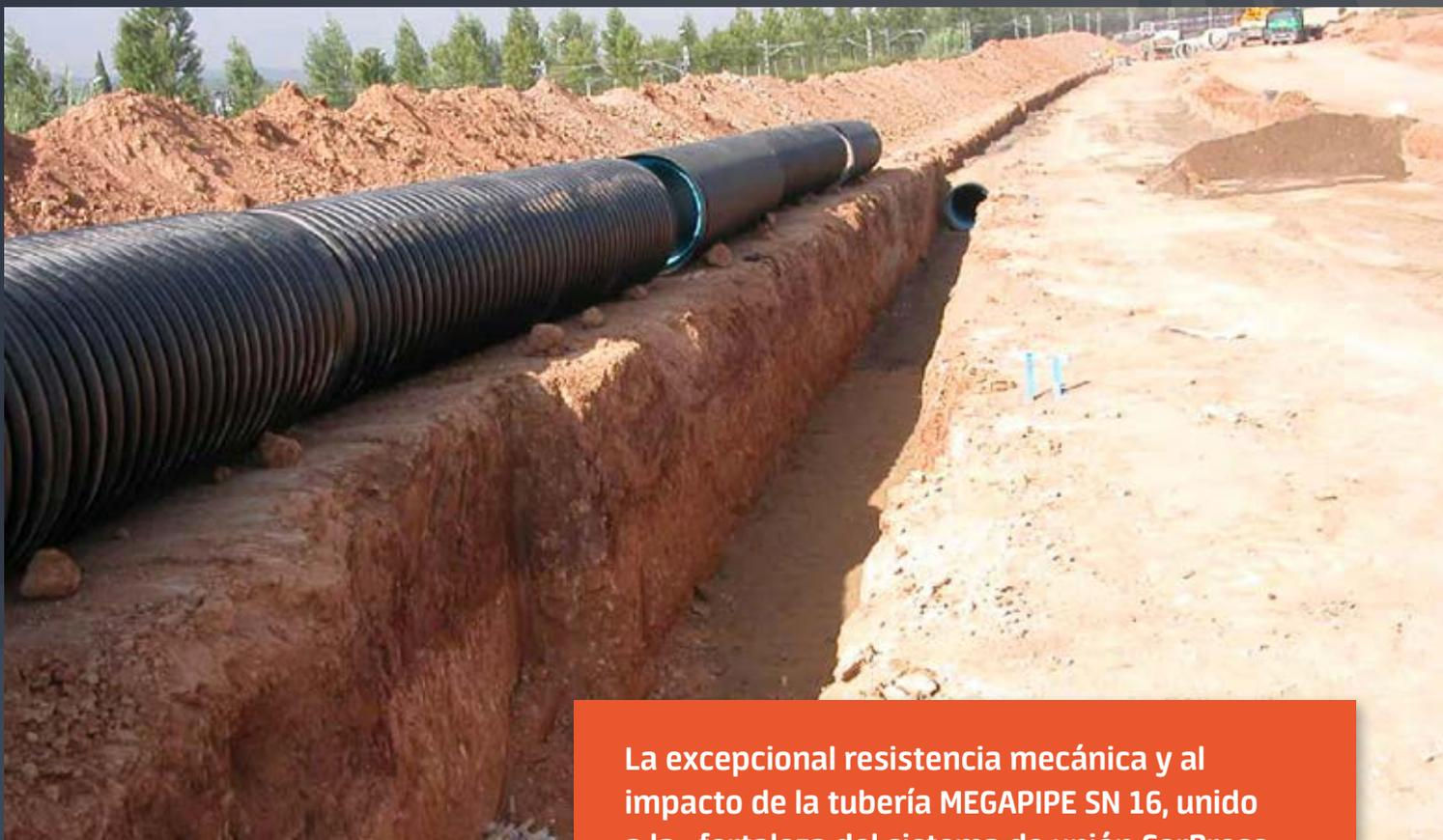
La excepcional resistencia mecánica y al impacto de la tubería MEGAPIPE SN 16, unido a la fortaleza del sistema de unión CorPress, permiten realizar el montaje fuera de la excavación para su posterior descenso a zanja. Con ello se asegura un aumento del rendimiento de montaje, mayor rapidez de instalación y mayor seguridad laboral.
